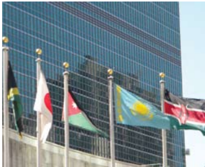
Здание ООН. г. Нью-Йорк
